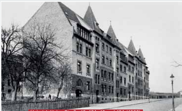
Heinrich-Heine-Straße 13, 13A, 15 und 15A (1899)
