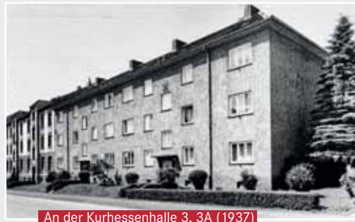
An der Kurhessenhalle 3, 3A (1937)
